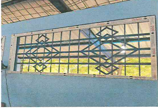
Foto1: Instalación de ventanas de PVC.
